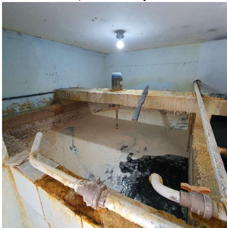
FIGURA 44 – PREPARAÇÃO DE PRODUTOS QUÍMICOS DE TRATAMENTO
