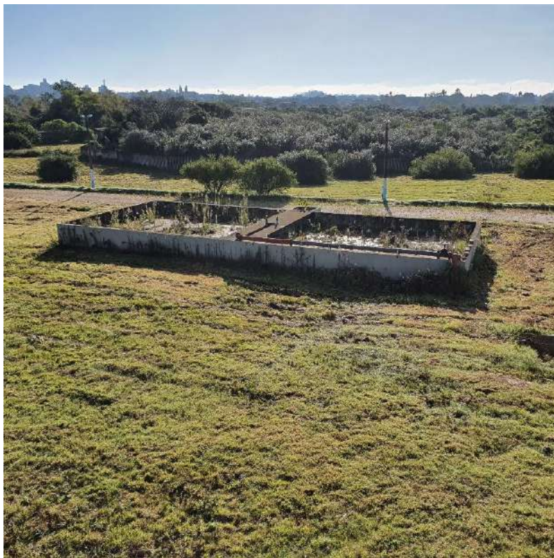
FIGURA 107 – LEITO DE SECAGEM – ETE CENTRAL
