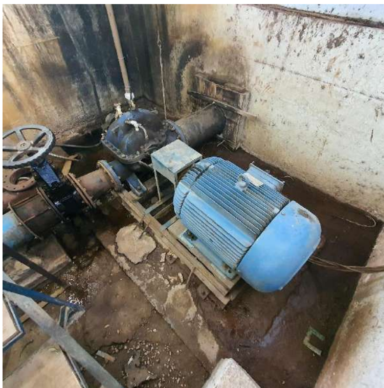
FIGURA 27 - EEAB - BARRAGEM EMERGENCIAL
