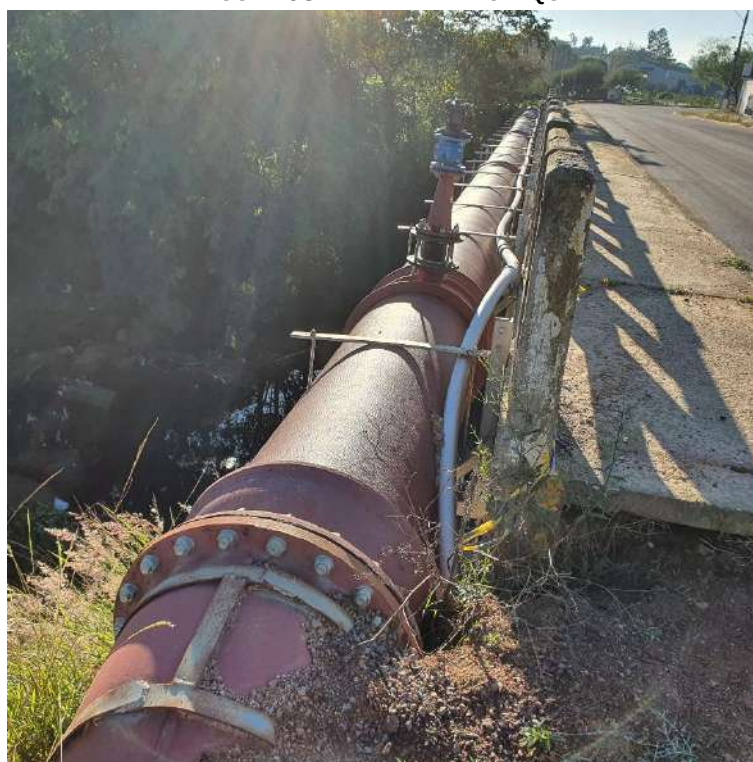
FIGURA 93 – LINHA DE RECALQUE
