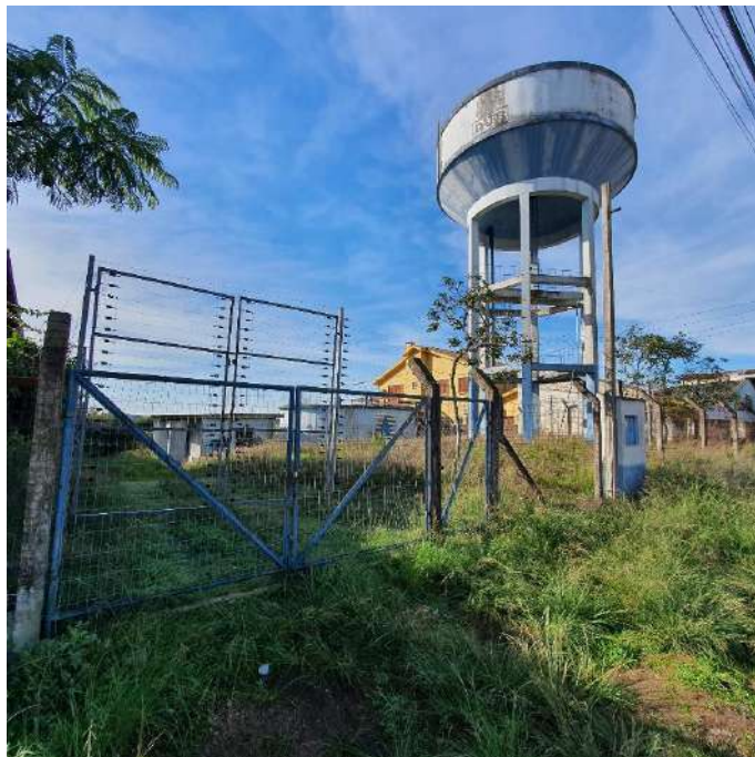
FIGURA 71 – ÁREA RAP E REL LARANJEIRAS
