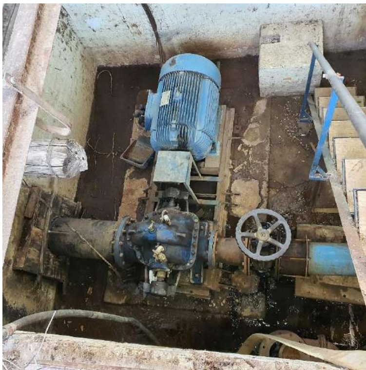
FIGURA 26 - EEAB - BARRAGEM EMERGENCIAL
