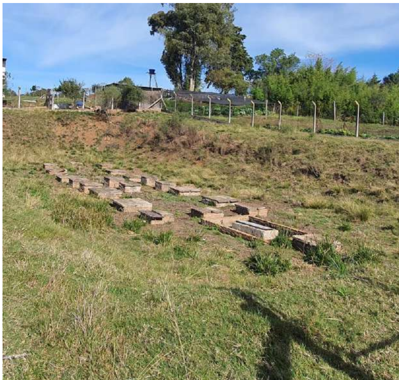
FIGURA 94 – ETE FOSSA FILTRO
