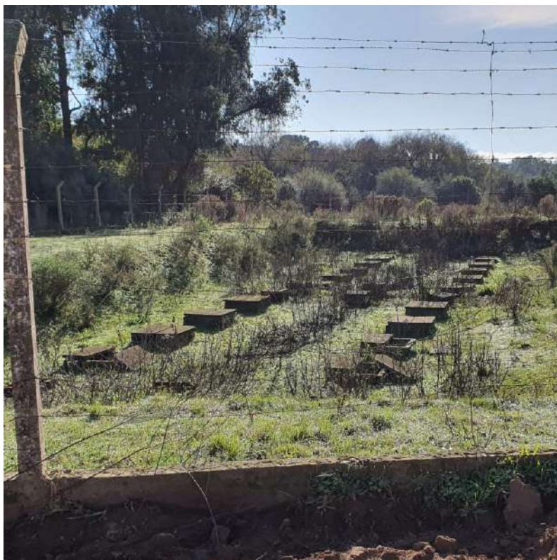
FIGURA 95 – ETE FOSSA FILTRO
