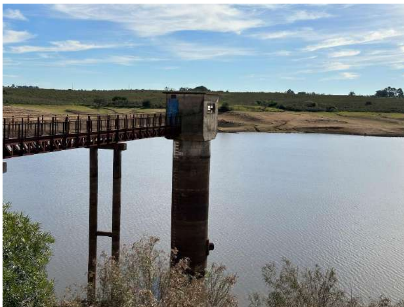
FIGURA 21 - BARRAGEM SANGA RASA
