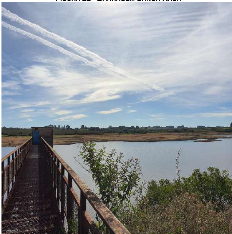
FIGURA 22 - BARRAGEM SANGA RASA
