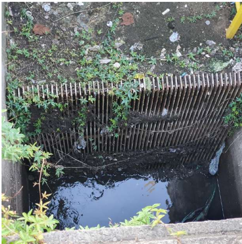
FIGURA 90 – GRADEAMENTO EEEB BAGÉ
