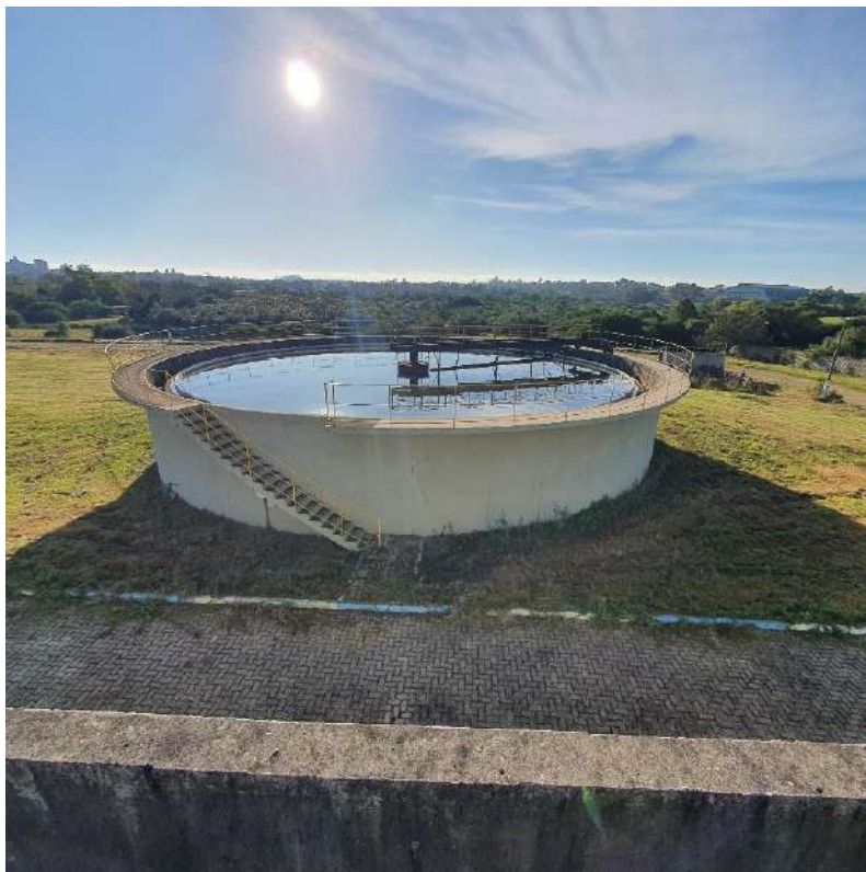
FIGURA 105 – DECANTADOR - ETE CENTRAL
