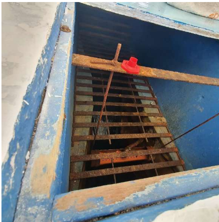
FIGURA 31 – CALHA PARSHALL E DOSAGEM DE SULFATO DE ALUMÍNIO
