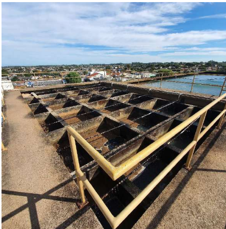
FIGURA 33 – FLOCULADORES HIDRÁULICOS
