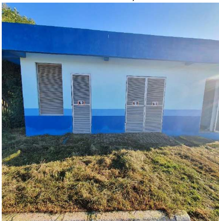
FIGURA 111 – ABRIGO SUBESTAÇÃO - ETE CENTRAL
