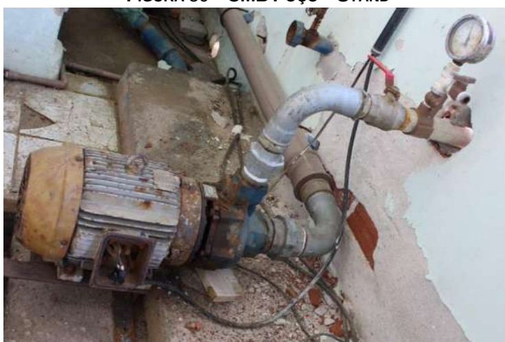
FIGURA 50 – CMB Poço – STAND
