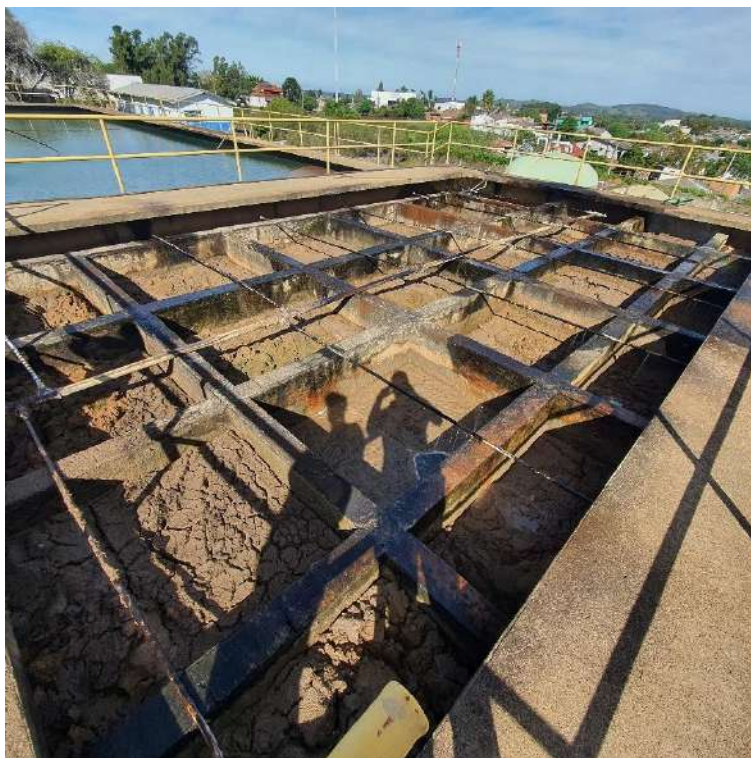
FIGURA 32 – FLOCULADORES HIDRÁULICOS
